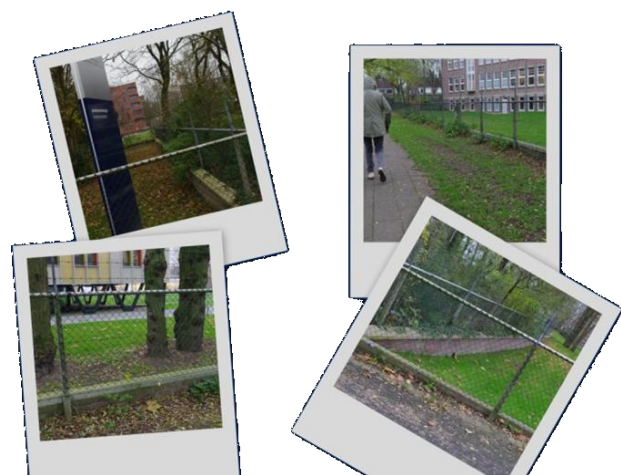
Eenvoudige adaptatiemaatregelen bij de Nobelweg in de vorm van muurtjes die het water weggeleiden en overstrooming voorkomen.
